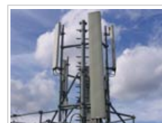
Estación base de telefonía móvil Fuente: Pyb
