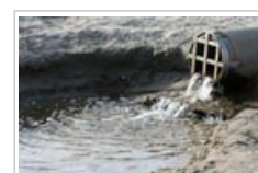
Des biocides sont rejetés avec les eaux usées.
